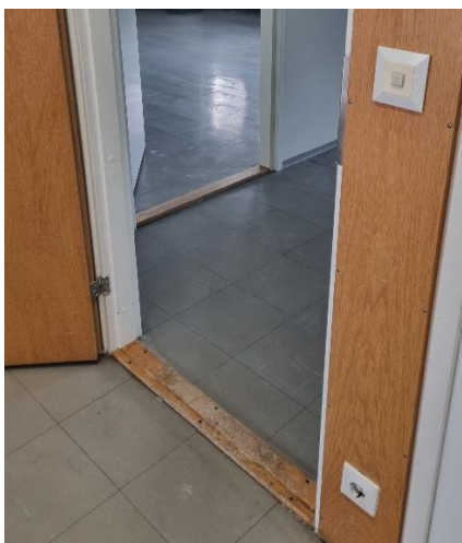
Kuva 7: Tuvan ja odotushuoneen 2 cm kynnys.
